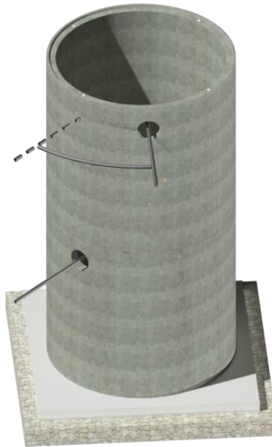
Obr. č. 10 již osazená prefabrikovaná skruž
