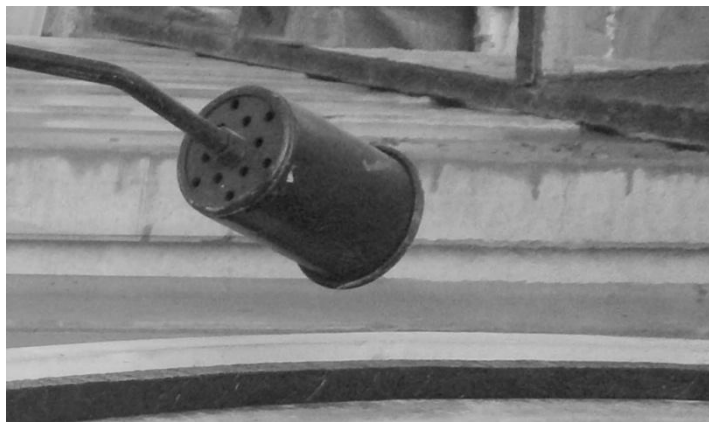
Obr. č. 8 nahřátí těsnícího pásku na 45°C pro zvýšení jeho adheze
