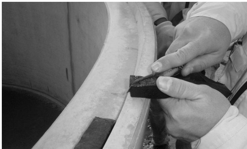
Obr. č. 6 seříznutí konců sousedních těsnících pásků
