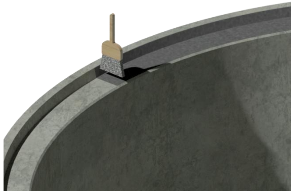
Obr. č. 4 natření povrchu spojů primer nátěrem - penetrací
