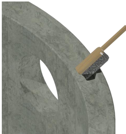
Obr. č. 2 očištění povrchů spoje prefabrikátů
