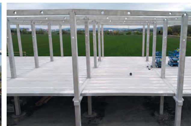
Cooper Bystřice nad Pernštejnem I. etapa - výrobní hala a Energo centrum - 10 500 m 2
