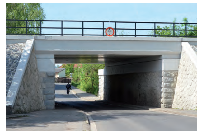
Česká Lípa deskové mostní nosníky
