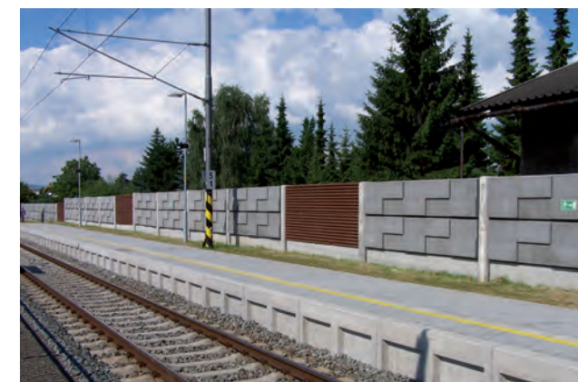
žst. Postřelmov železobetonové pražce B 91 S, nástupištní hrany L 130, protihluková stěna Silent
