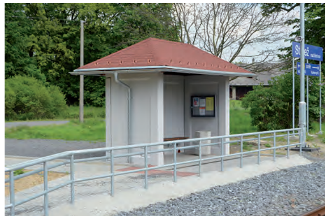
železniční zastávka Střítež nástupištní přístřešek
