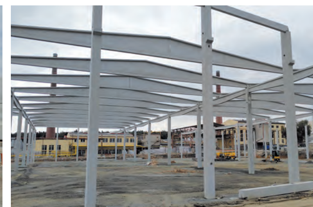
Lassersberger Chlumčany výrobní a skladová hala - 11 000 m 2
