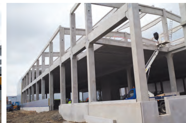
Kovona Český Těšín výrobní hala - 8 600 m 2
