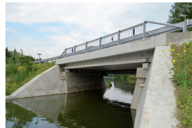
Kostelec mostní nosníky VSTI
