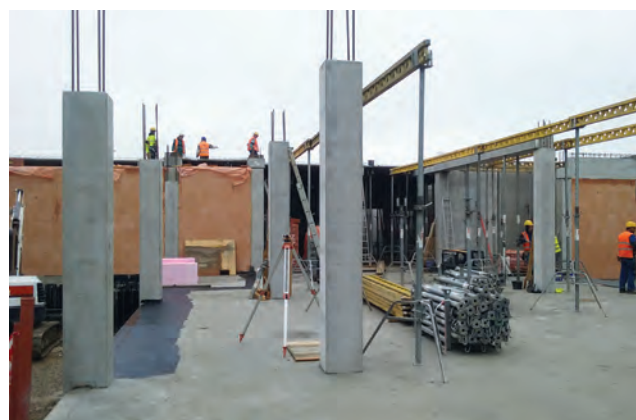
Rekonstrukce pavilonu nemocnice Jindřichův Hradec nový pavilon dětské nemocnice, 4. nadzemní podlaží
