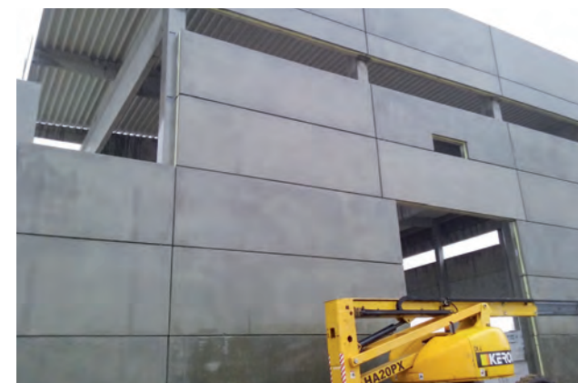
ACO Příbyslav skladová a výrobní hala - 3 500 m 2
