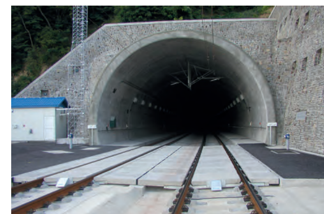
tunel Turecký Vrch pevná jízdní dráha Rheda 2000, zádlažbové panely Brens Access
