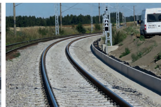
železniční trať Ostrov nad Oslavou-Žďár na Sázavou železobetonové pražce, příkopové žlaby
