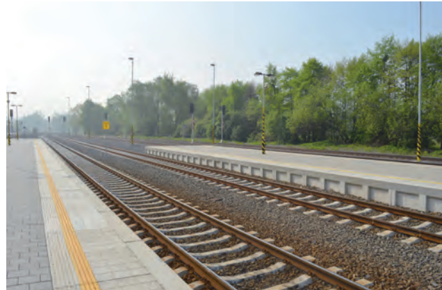
žst. Frýdlad nad Ostravicí železobetonové pražce B 91 S, nástupištní hrany H 130, nástupištní dlažební desky
