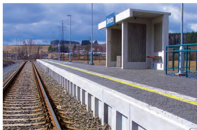
železniční zastávka Diwnice železobetonové pražce, nástupištní hrany L 130, nástupištní přístřešek
