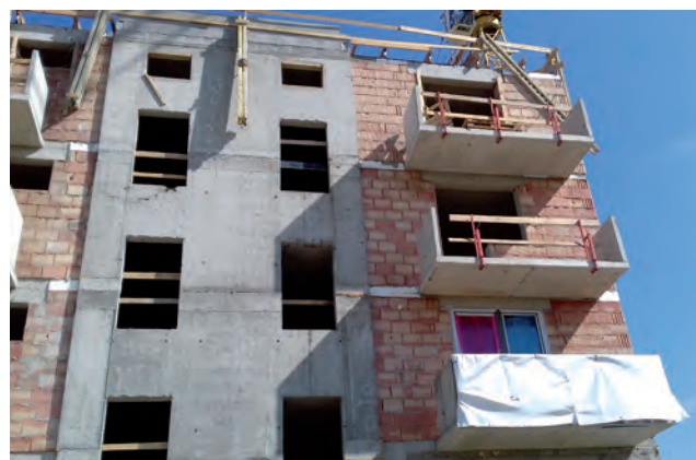
Bytový komplex Za Velkou Branou schodišťová ramena, úťahové šachty
