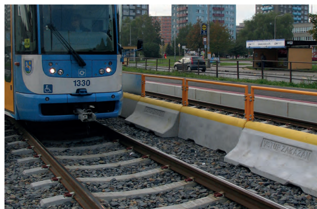
tramvajová trať Ostrava železobetonové pražce B 03, zábrany BRENS® BARRIER
