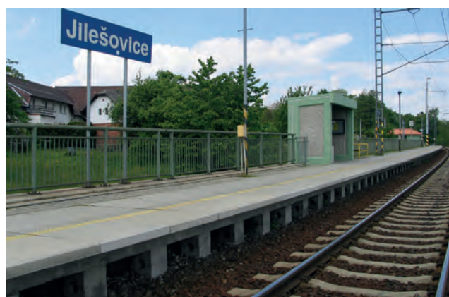
železniční zastávka Jilešovice železobetonové pražce B 91 S, nástupiště Sudop, nástupištní přístřešek
