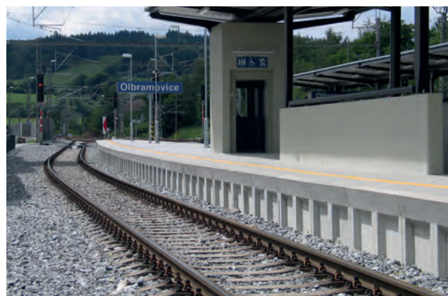
žst. Olbramovice železobetonové pražce, nástupištní hrany H 130
