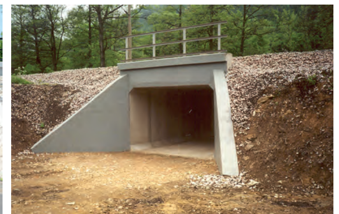
železobetonové rámy DZR
