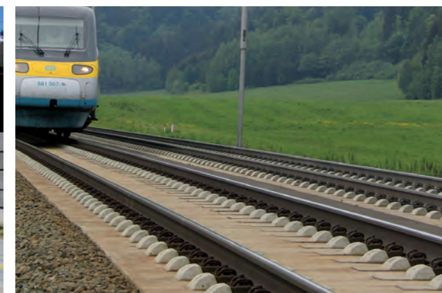
železniční trať Třebovice-Rudoltice pevná jízdní dráha Rheda 2000
