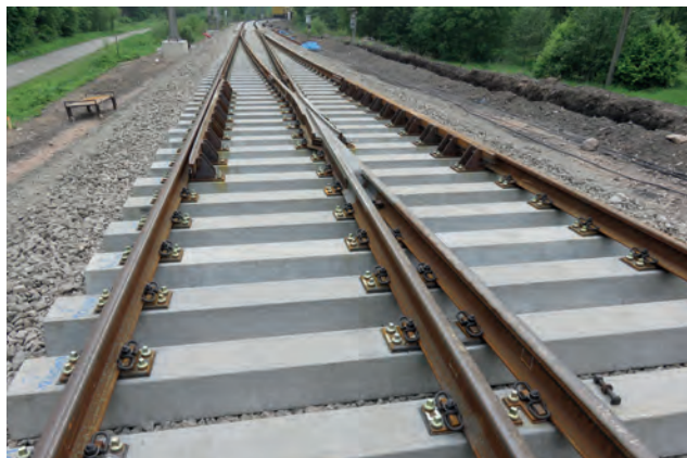
železniční trať Ústí nad Orlicí-Letohrad železobetonové výhybkové pražce
