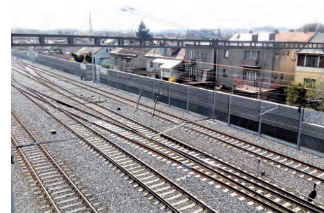
žst. Český Těšín železobetonové pražce, protihluková stěna
