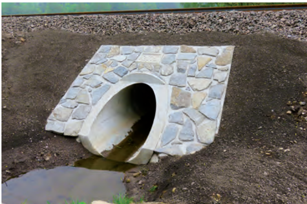
Železniční trať Ústí nad Orlicí – Letohrad šikmá železobetonová trouba patková
