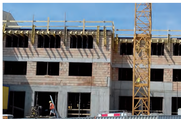
Polyfunkční dům Bohdalec schodišťová ramena
