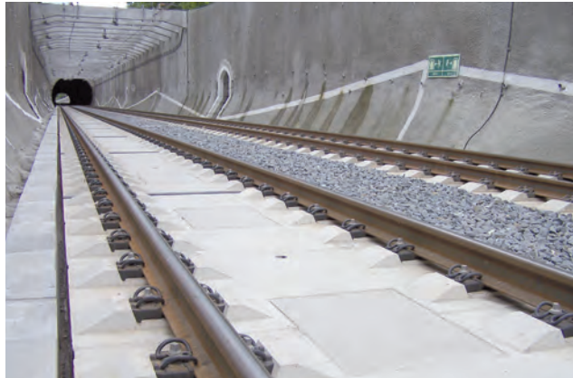
žst. Střelná pevná jízdní dráha PORR
