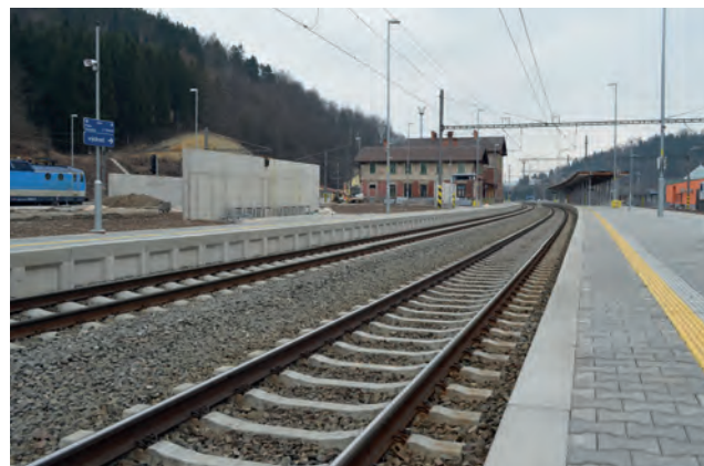
žst. Ústí nad Orlicí železobetonové pražce, nástupištní hrany H 130
