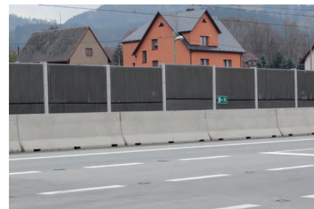
Hrádek betonová suodidla BSV
