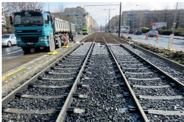
tramvajová trať - Praha - ul. Vršovická železobetonové pražce
