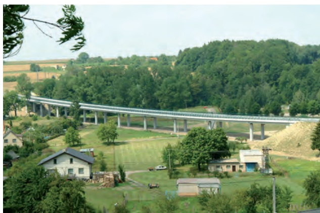
obchvat Vamberku mostní nosníky MK-T
