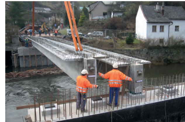
Úpice mostní nosníky MK-T
