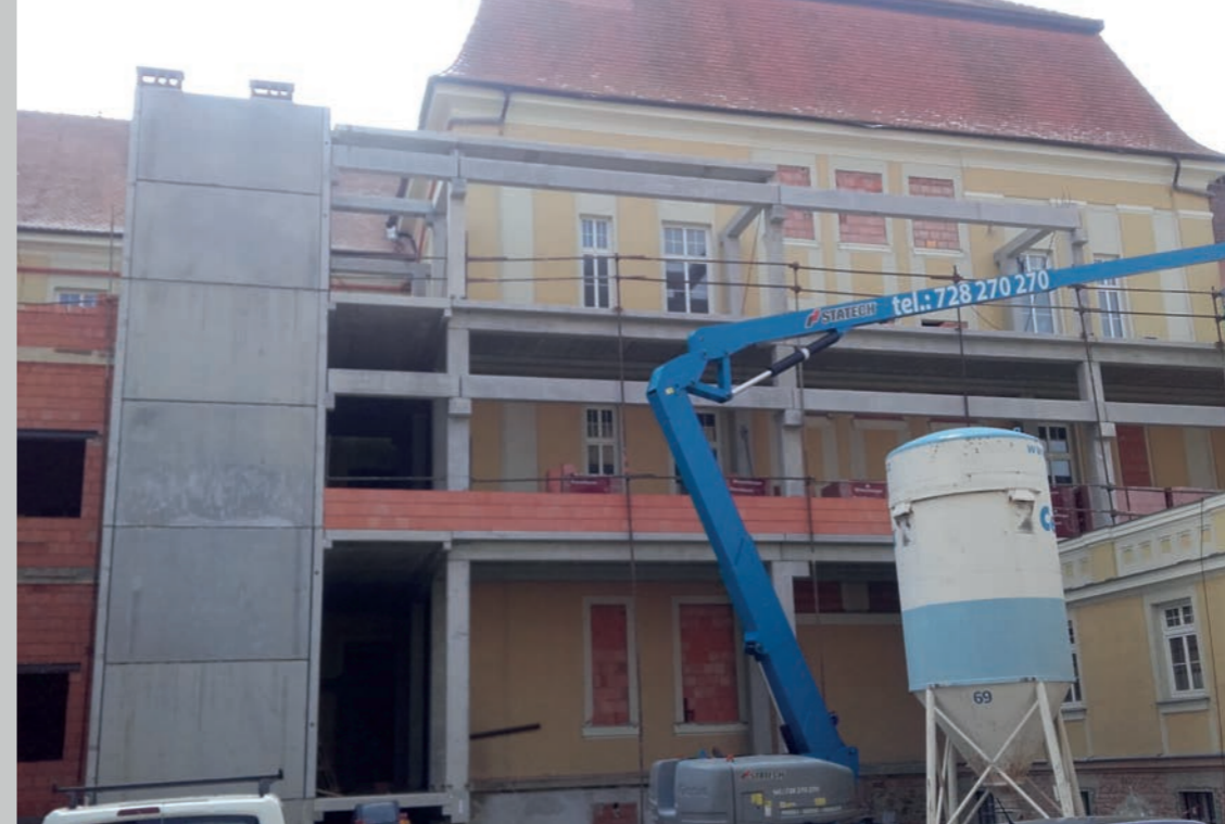
Rekonstrukce pavilonu „A“ České Budějovice
